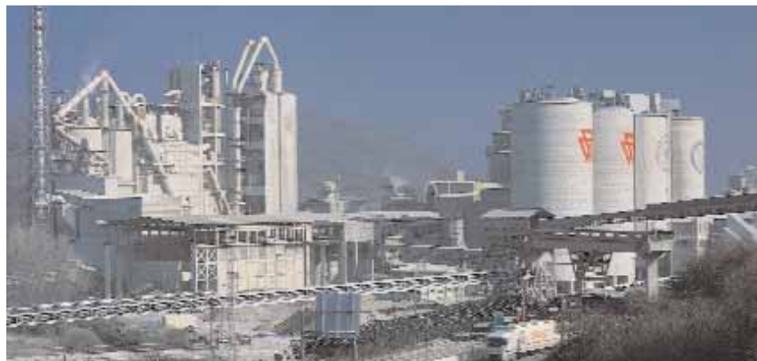
■ Cement factory in Olazagutía. Navarra
